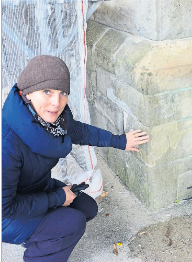
Architektin Sandra Risch zeigt eine ausgebesserte Stelle im Mauerwerk, die noch mit Silikatkreide nachgebessert werden wird.
