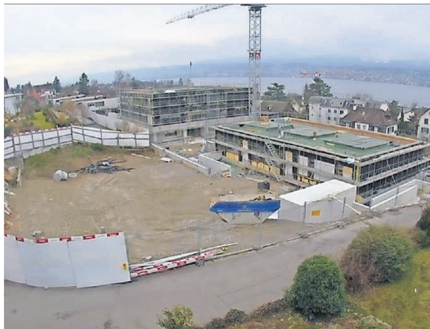
Bald sollen auf den beiden Dächern des Schulhauses und des Kindergartens Solarpanels angebracht werden. Foto: Screenshot Webcam, Schule Küsnacht
